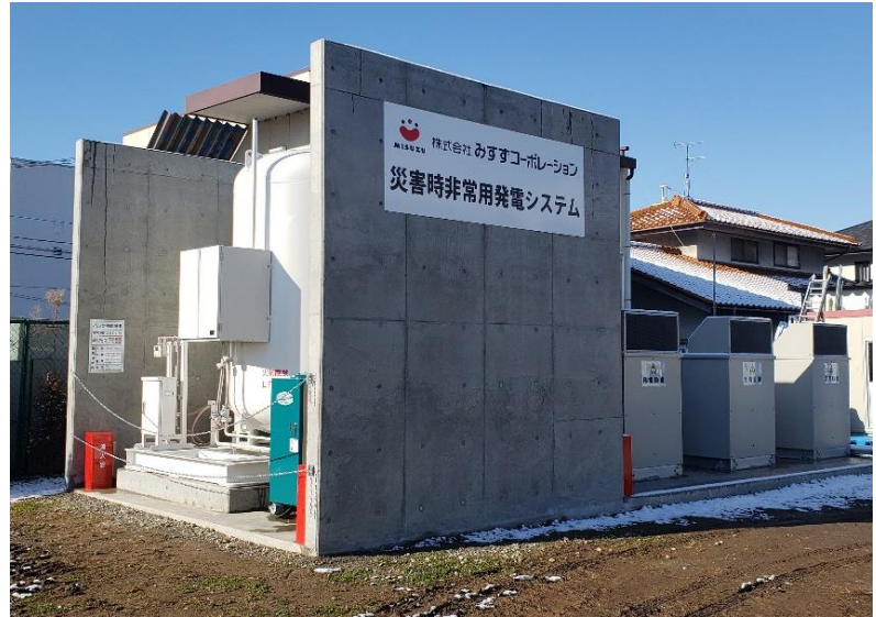
LPガス非常用発電機
