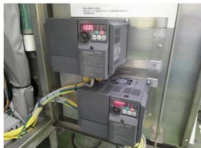
スチーマーの操作盤に真空ポンプ用のインバーターを設置し、吸引時間6.8秒間のみ、さらに周波数を60Hzから40Hzに下げ、真空ポンプのモーターを回転させる稼働を開始した。
